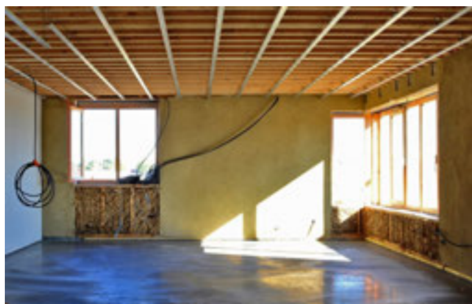
Exemple de chantier de logements collectifs neufs à ossature bois, isolation paille, enduit et cloisons en terre, au cours duquel même les futurs habitants ont pu mettre « la main à la pâte » en collaboration avec les entreprises. Immeuble La Ruche, Bègles (33, Axanis). Crédit photos : © Dauphins Architectes, Faïçal Oudor / Habitat Naturel.
