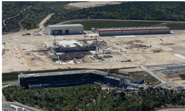
*Les grands chantiers en cours ou déjà réalisés sur le site ITER : au fond, ateliers de fabrication pour le cryostat et les aimants de champ poloidal ; au centre, fosse sismique et fondations du bâtiment d'assemblage ; au premier plan, le siège d'ITER Organization ([www.iter.org](http://www.iter.org)).*
